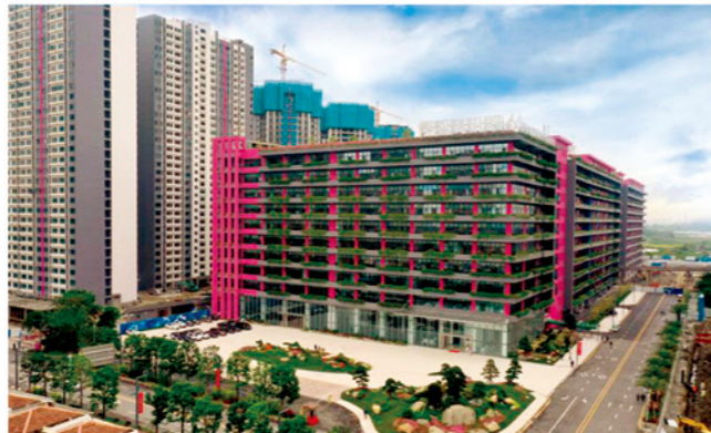
共同育人企业—碧桂园集团旗下的广东博智林机器人公司大楼
