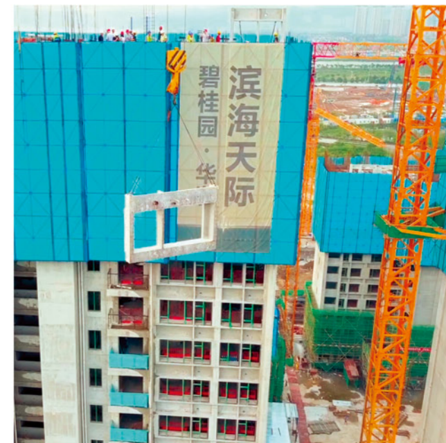
装配式建筑窗户安装
