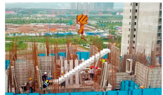
装配式建筑楼梯安装
