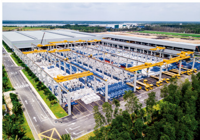
碧桂园装配式预制构件厂
