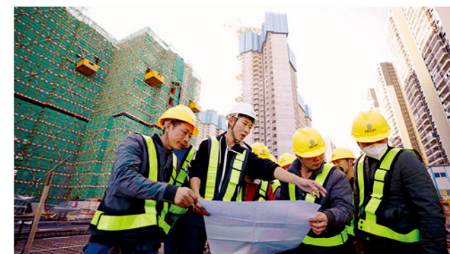
企业实践学生郭县生指导团队施工
