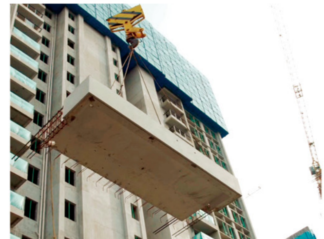
装配式建筑阳台安装
